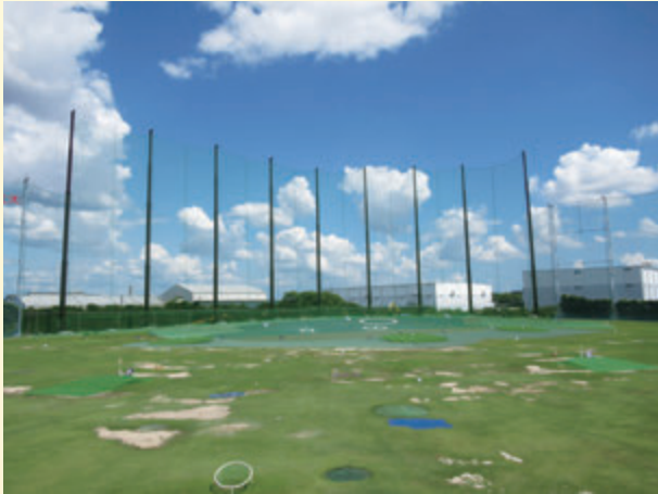
20m高く整備された防球ネット
