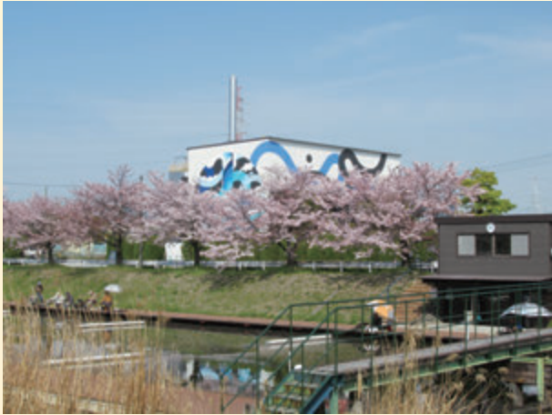
釣堀とNPLWバイオマスパワープラントのチップヤードの建屋
