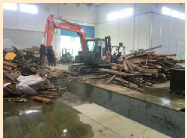
地下破砕機への投入口
