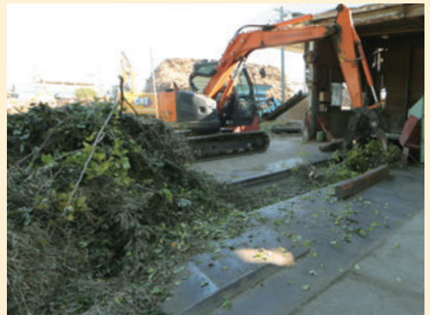
剪定枝葉をベルトコンベアーに投入
