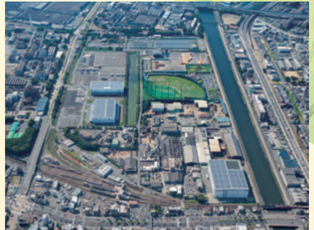
本社側から全景を望む
