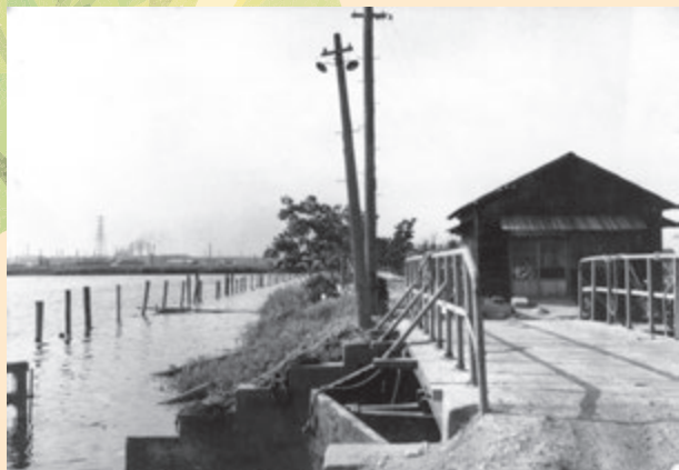
加福貯木場現場事務所
