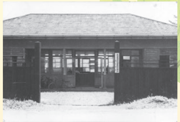
8号地貯木場現場事務所
