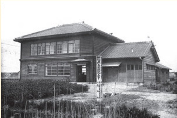
本社社屋、中央には「加福貯木池新設工事」の立て札がある
