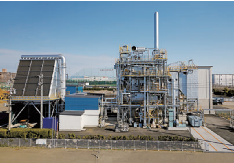
NPLW バイオマスパワープラント外観
